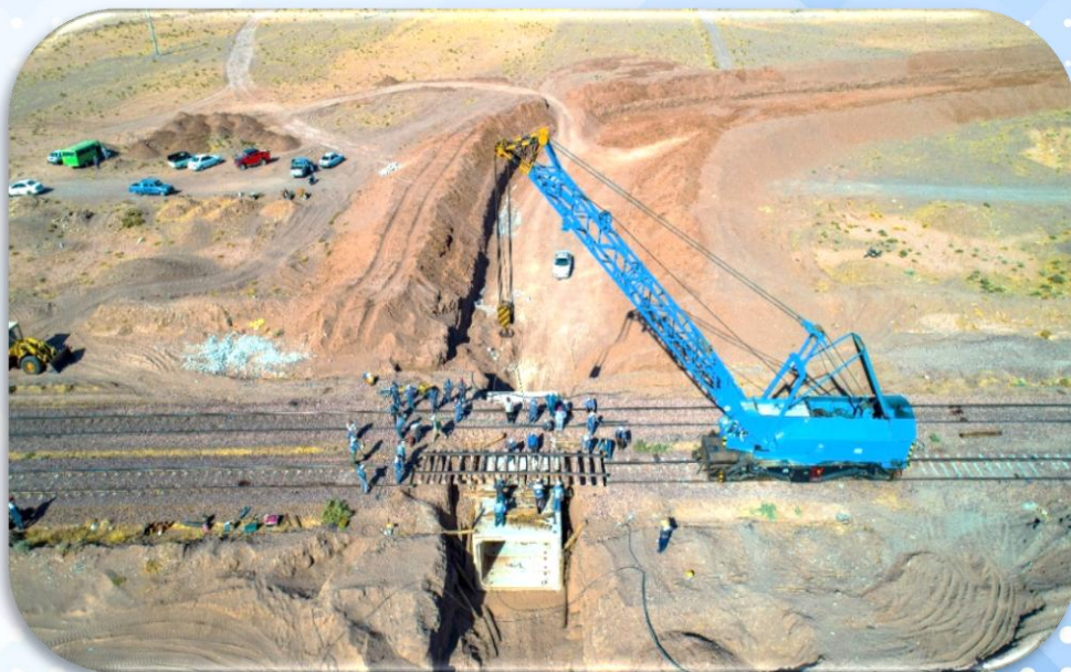
عملیات زیرسازی و ریل‌گذاری شرکت خط و ابنیه فلق
